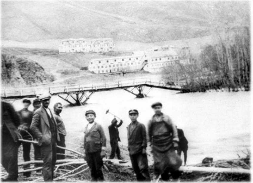
Ek 6.6. Yol Yapımında Çalışan İşçiler
