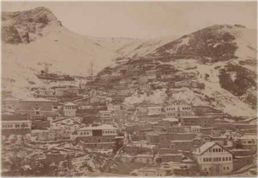
Ek 6.2. Eski Gümüşhane'den Bir Görünüm - Cami-i Sagır Mahallesi
